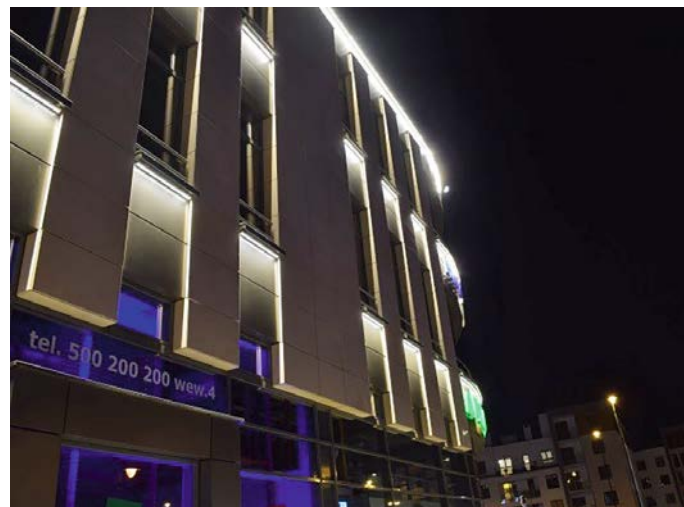
Рис. 2. Способ загоразивания светильников на фасаде ТЦ Sezam
