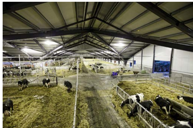
Рис. 2. СД освещение в животноводческом комплексе для КРС [6]
