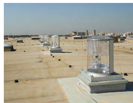
Рис. 9. Общий вид на крышу (кровлю) СТЦ
