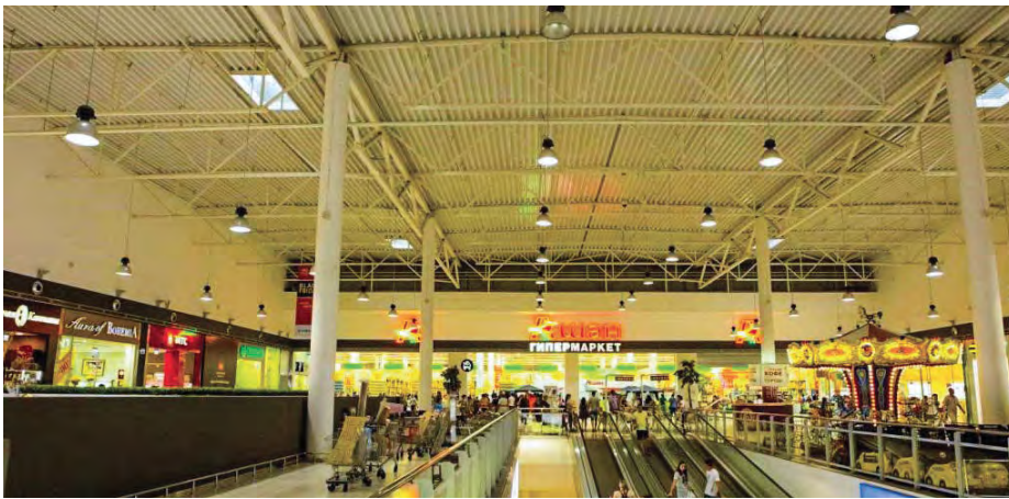
Рис. 6. Осветительная система до реконструкции – постоянно действующая ОУ искусственного света. Источники света – МГЛ ВД
