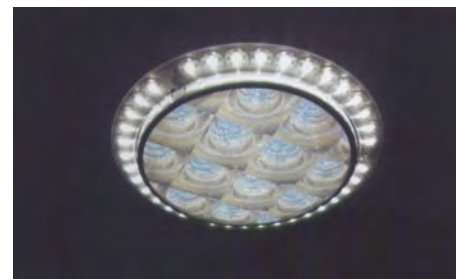
Рис. 1. Гибридный осветительный комплекс « LED+«Solarspot» » (диаметр световода 375 мм). Реализован в 2010 г. компанией Solarspot International S.r.l.
