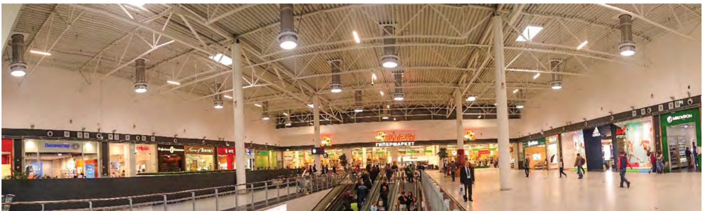
Рис. 7. Вид зала после реконструкции осветительной системы с помощью ГОК «Solar-LED»
