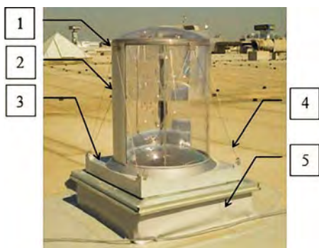
Рис. 3. Вводный узел ГОК на крыше СТЦ: 1 – коллектор; 2 – отражающая пластина «LightTracker™»; 3 – бордюрный флешинг; 4 – трос противовеетровой нагрузки; 5 – бордюр
