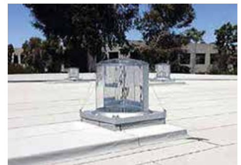
Рис. 4. Коллектор Solatube® M74 серии SkyVault (740 мм) на крыше здания. Сочетание коллектора и линз Френеля на куполе (технология Raybender® ) обеспечивает постоянство светового потока в течение всего светового дня, в том числе в утренние и вечерние часы, за счёт улавливания световых лучей при низких углах солнцестояния
