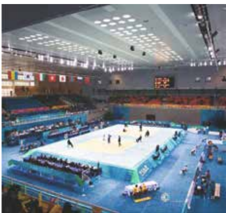
Рис. 10. Освещение спортивного зала Пекинского университета системами Solatube®. Зал вместимостью более 8000 зрителей (площадь около 2400 м 2 ) был освещён 148 моделями Solatube® 750 DS (530 мм, серия Solatube® SoloMaster®) с рассеивателем OptiView® для открытого потолка и устройством управления Daylight Dimmer™
