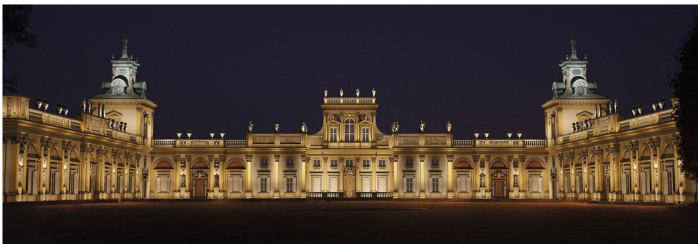
Рис. 5. Компьютерная модель освещения заливающим светом дворца-музея Виланов, вариант II, отказ от подчёркивания ритма колонн и тялястров
