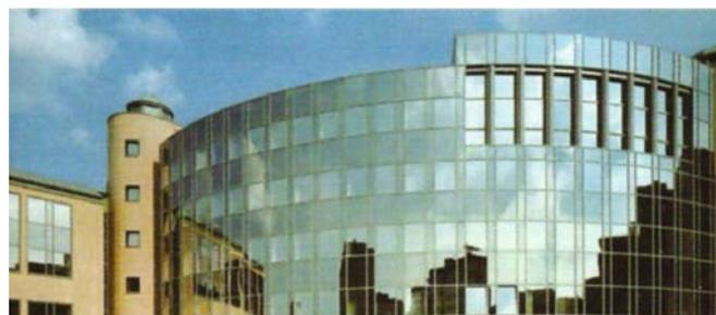
Рис. 2. Отражение противостоящих зданий в стандартном зеркальном фасаде с переплётами
