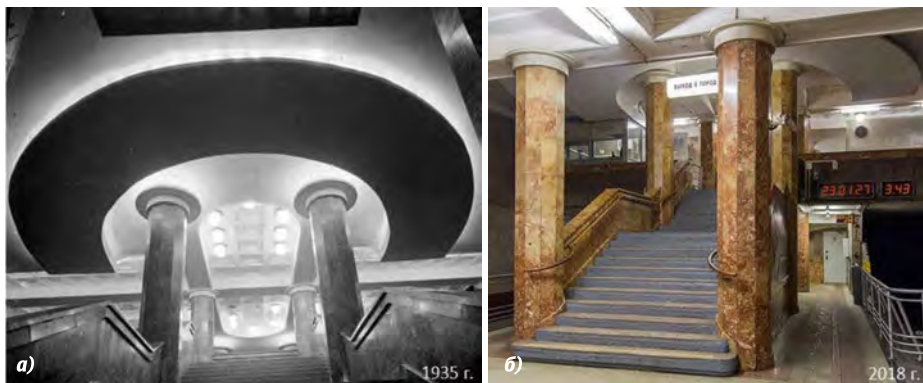
Рис. 3. Внешний облик лестничного марша зоны перехода станции «Красносельская»: а – 1935 г., б – 2018 г.
