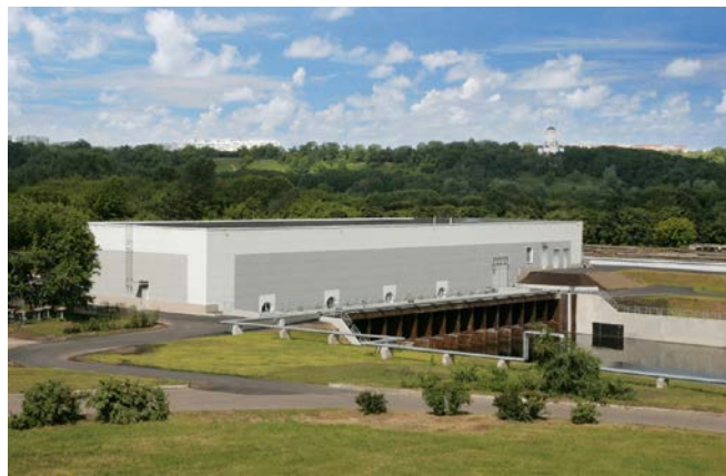
Рис. 3. УФ станция обеззараживания на Курьяновских очистных сооружениях (г. Москва). (Всего 6120 ламп типа ДБ600В, суммарная потребляемая мощность 3,7 МВт)
