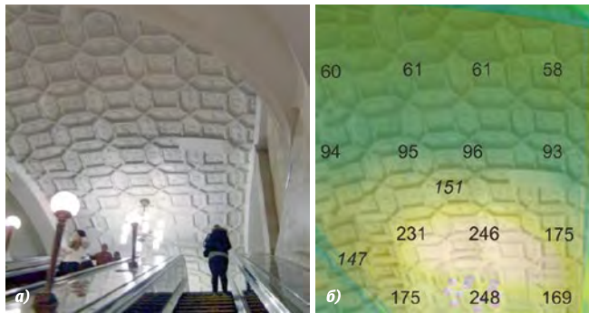
Рис. 4. Внешний вид потолка вестибюля и характер его освещения до реконструкции ОП: а – внешний вид; б – распределение освещённости (лк)
