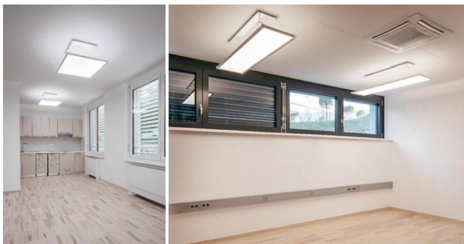
Рис. 8. Подвесные светильники SKY LUM обеспечивают низкий световой градиент от потолка и светящейся поверхности, создавая низкую блёккость и правильные углы освещения для процессов НВ
