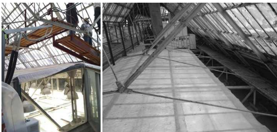
Рис. 10. Внутреннее пространство и внешний вид подфонарника
