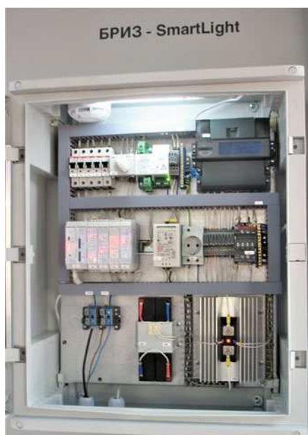
Рис. 1. Система управления освещением «Бриз» (МСК БЛ Групп)
