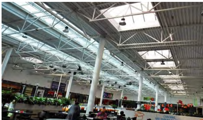
Рис. 5. Типовое верхнее естественное освещение зала № 2: прозрачная кровля и зенитные фонари
