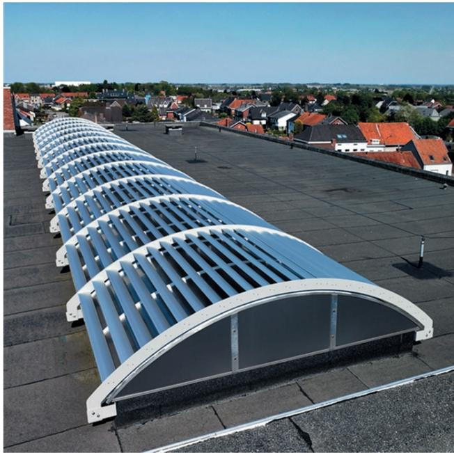
Рис.5. Наружные солнцезащитные регулируемые экраны
