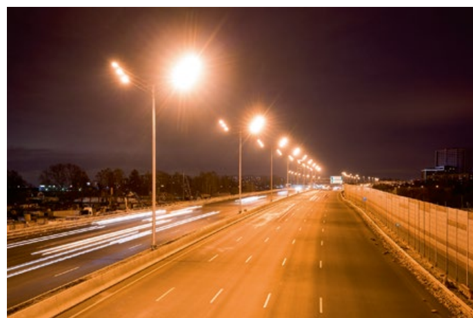
Рис. 4. Освещение автомагистрали М-11 (от Москвы до Шереметьево)
