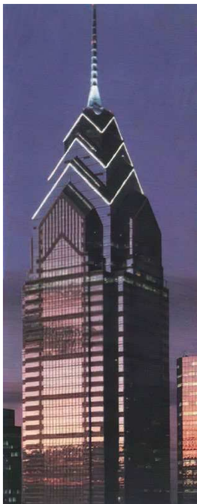
Рис. 9. Световоды на шпигеле небоскрёба в Филадельфии
