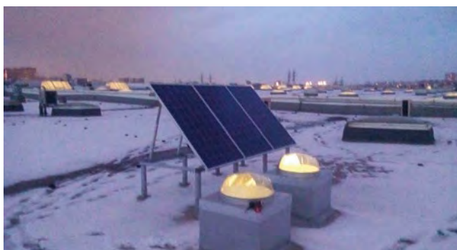
Рис. 9. Вид на крышу. Вводный узел ГОК и солнечные панели
