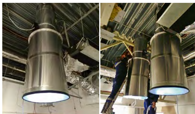
Рис. 7. ГОК «Solar LED-S» в помещении «Комната переговоров» (процесс монтажа). СБИС размещён в пространстве технического этажа, расположенного над потолком этого помещения под кровлей (внутреннее исполнение)
