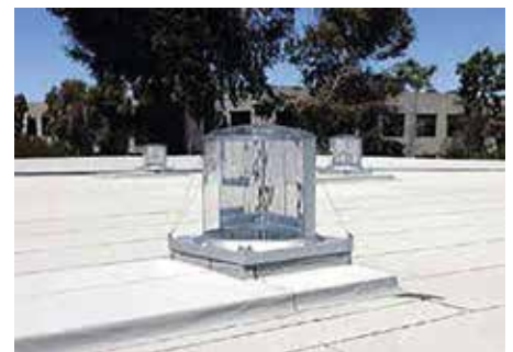
Рис. 4. Коллектор Solatube® M74 серии SkyVault (740 мм) на крыше здания. Сочетание коллектора и линз Френеля на куполе (технология Raybender® ) обеспечивает постоянство светового потока в течение всего светового дня, в том числе в утренние и вечерние часы, за счёт улавливания световых лучей при низких углах солнцестояния
