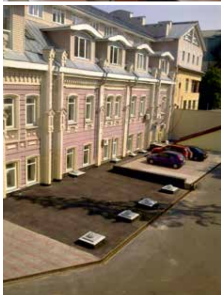
Рис. 8. Модель Solatube ® 290DS в освещении подземных помещений Правовой академии (Нижний Новгород)
