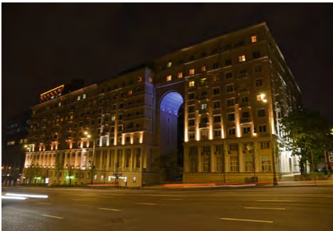
Рис. 3. Земляной Вал. Городская программа освещения. То ли световой хаос, то ли «световой беспредел»
