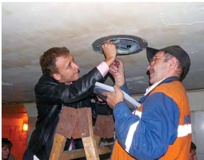
Рис. 4. Монтаж светильника GALAD ДВУ25. Светильник устанавливает сотрудник компании X-Light Владислав Терехов (слева), в настоящее время – директор по продвижению ООО МСК «БЛ ГРУПП»
