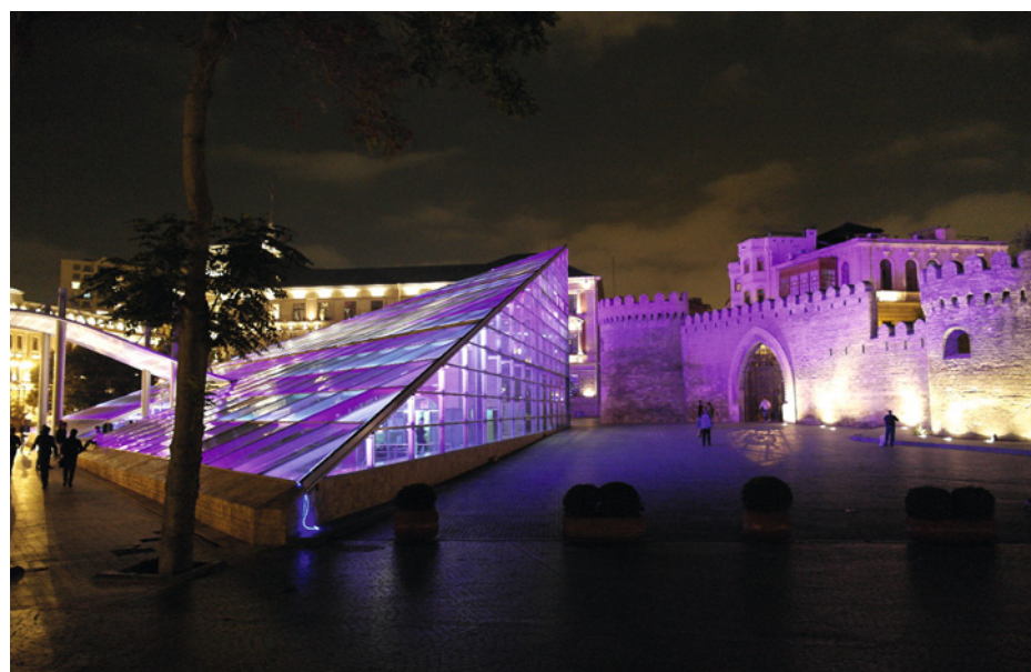
Рис. 7. Наземный вестибюль станции метро «Ичеришехер» с цветодинамическим освещением
