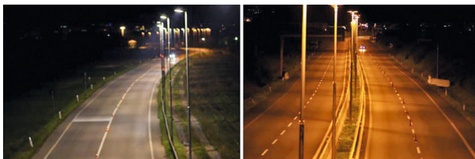
Рис. 3. Установка дорожного освещения в Морнико (слева) и Тревиоло (справа)
