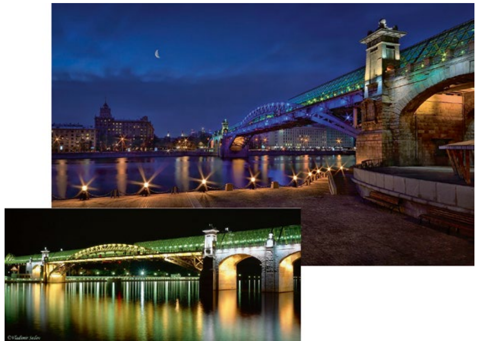
Рис. 1. Андреевский мост, г. Москва
