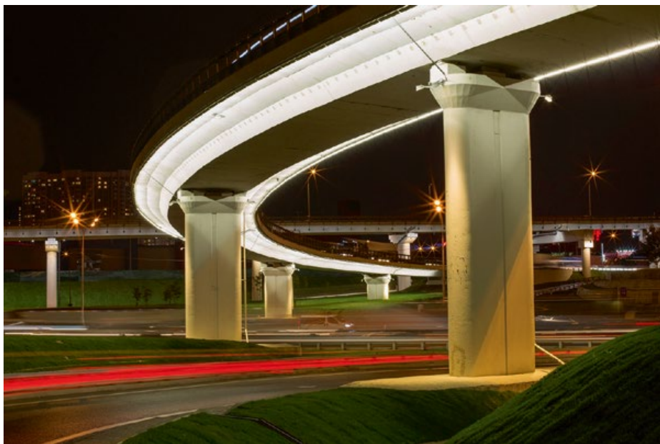
Рис. 5. Пример применения светильников со светодиодами «Альтаир» и «Аврора» (эстакада на пересечении Ленинградского шоссе с МКАД, г. Москва)
