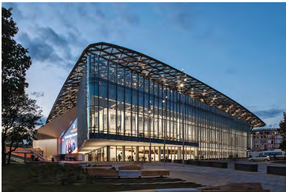
Рис. 3. Общий вид с юго-востока. На южном фасаде размещён светодиодный экран и выделена подсветкой пластика стены. Фотография: А. Народицкий
