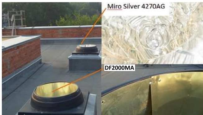
Рис. 6. Вид зеркального тубуса световода на основе полимерной плёнки «DF2000MA» после определённого срока эксплуатации без УФ поглощающего фильтра
