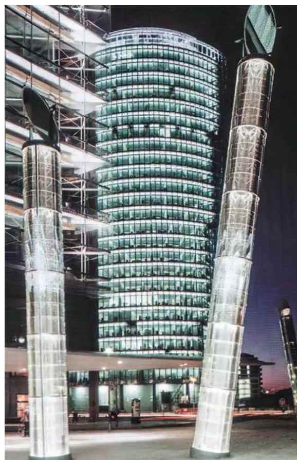
Рис. 14. Два световода 15–20 м длиной на Potsdamen Platz в Берлине для создания впечатления зрительной связи наружного и внутреннего пространства подземного торгового центра и прогулочной зоны
