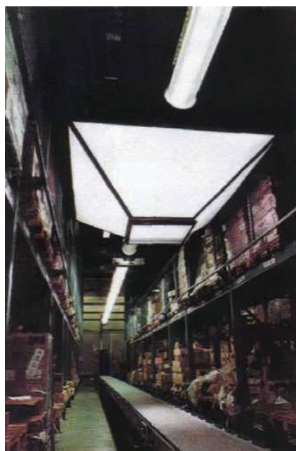
Рис. 13. Освещение здания Copriano в Милане с помощью полых световодов с корзинообразным центральным узлом
