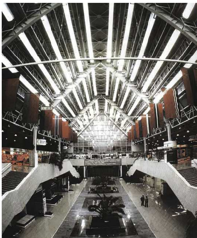
Рис. 3. Освещение павильона товаров народного потребления на ВДНХ в Москве десятью линиями световодов КОУ 3×700 длиной по 36 м каждый в линии
