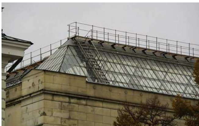
Рис. 6. Внешний вид светопрозрачного покрытия в 2018 г.
