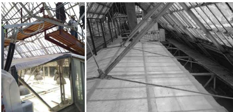
Рис. 10. Внутреннее пространство и внешний вид подфонарника
