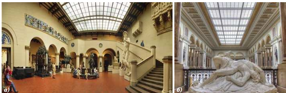
Рис. 3. Системы верхнего естественного освещения музеев: а – один из главных залов ГМИИ; б – аналогичный зал Дворца изящных искусств в Лилле
