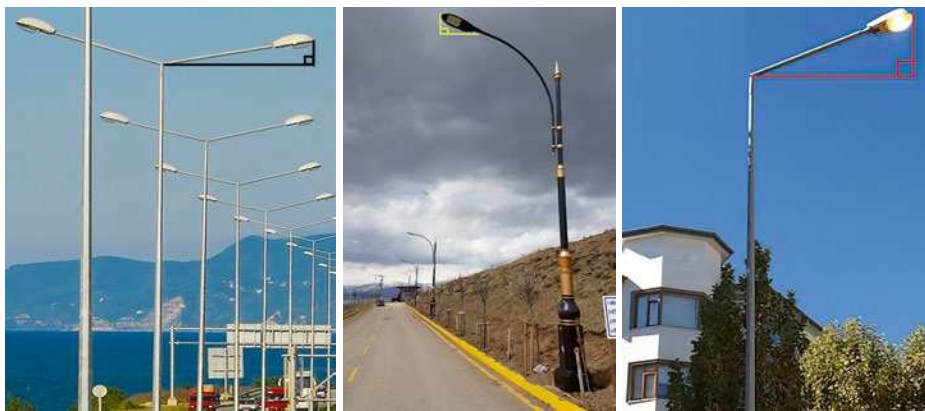
Рис. 1. Примеры углов наклона консолей светильников дорожного освещения
