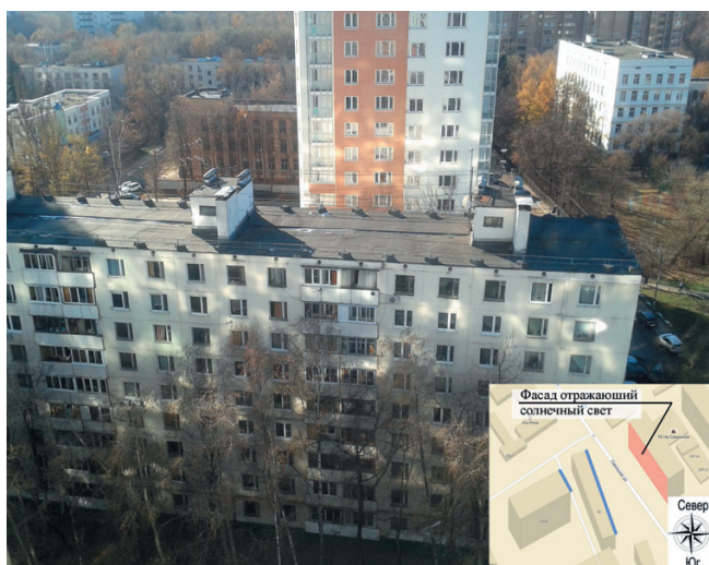
Рис. 5. Фотография восточных, и северо-восточных фасадов зданий по адресу: г. Москва, ул. Смольная, д. 33 и 41, к.4 с падающим на них солнечным излучением, отражаемым окнами западного и юго-западного фасадов здания, расположенного по адресу: г. Москва, ул. Смольная д., 24а. Фотография сделана 24.10. 2014 в 15:03
