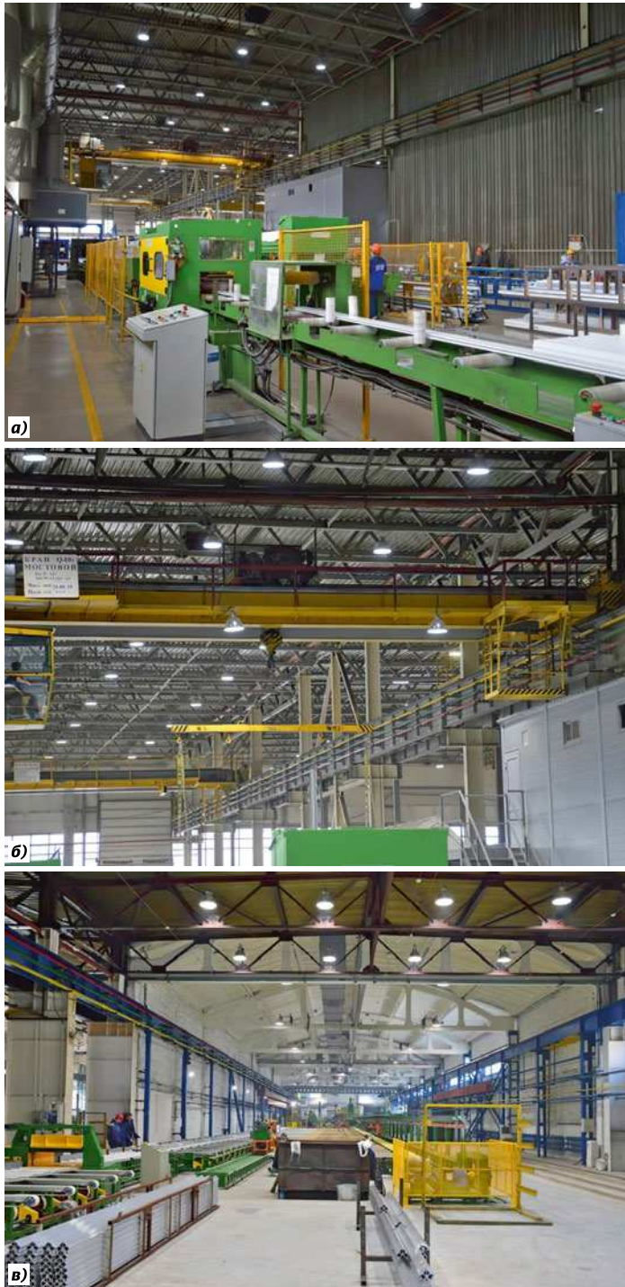
Рис. 2. Освещение цехов ЛПЗ после модернизации ОУ: а и б – корпус № 4, пролёт № 5, автоматическая упаковочная линия окрашенного профиля; в – корпус № 2, цех (с прессом с усилием 2500 тс)
