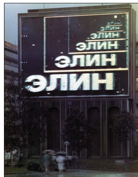
Рис. 5. «Элин 2» – экран на вакуумно-люминесцентных индикаторах. Фото 1985 г.
