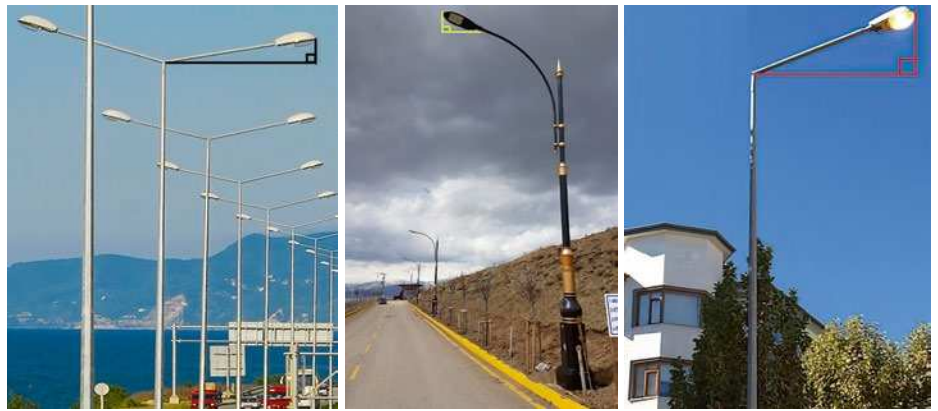
Рис. 1. Примеры углов наклона консолей светильников дорожного освещения
