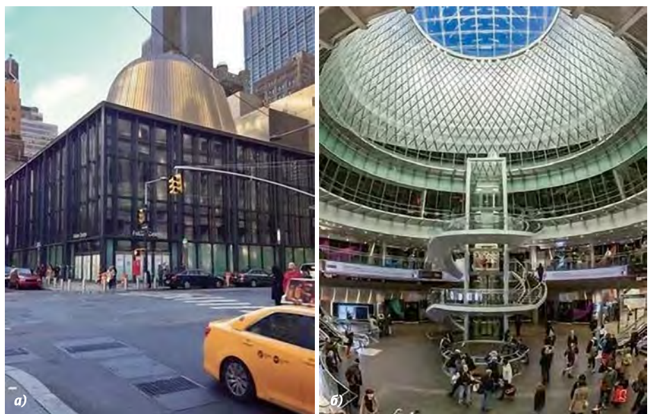
Рис. 2. Ловушка света в транспортном пересадочном узле « Fulton Center » (Нью-Йорк): а – общий вид здания узла; б – внутреннее пространство с сетчатой структурой купола
