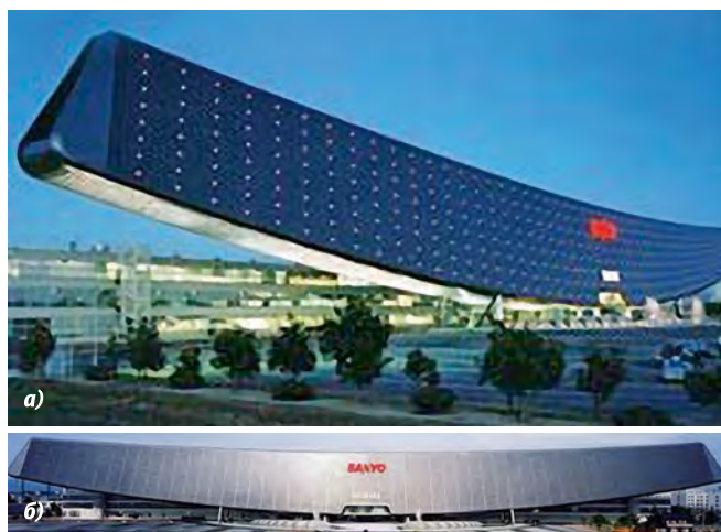
Рис. 13. Памятник солнечной энергии «Солнечный ковчег» (Япония): а – фасад; б – общий вид
