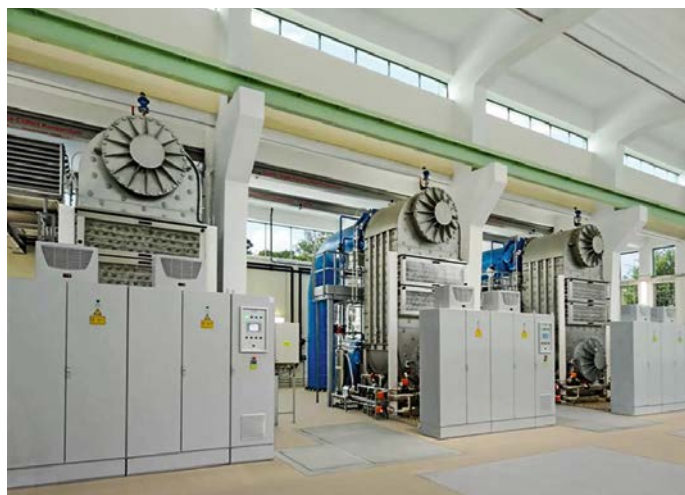
Рис 2. Станция УФ обеззараживания поверхностной воды (г. Будапешт, Венгрия). (Всего 600 ламп типа ДБ350, суммарная потребляемая мощность 210 кВт)
