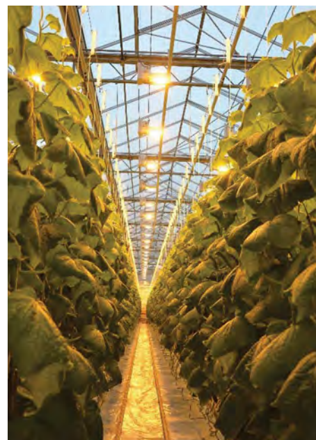
Рис. 5. Лампы ДНаЗ Reflux в теплице
