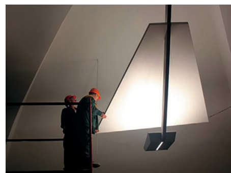
Рис. 17. «Новокосино». Монтаж фрагмента световой конструкции
