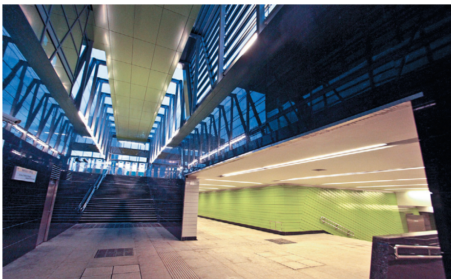
Рис. 16. «Лермонтовский проспект». Спуск из наземного павильона в подземный пешеходный переход
