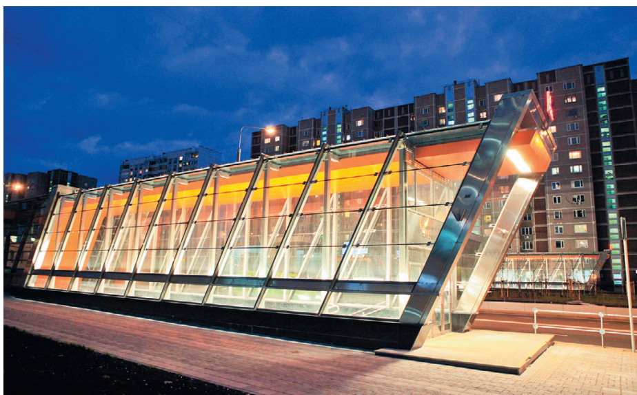
Рис. 14. «Жулебино». Павильоны над лестничными сходами в метро
