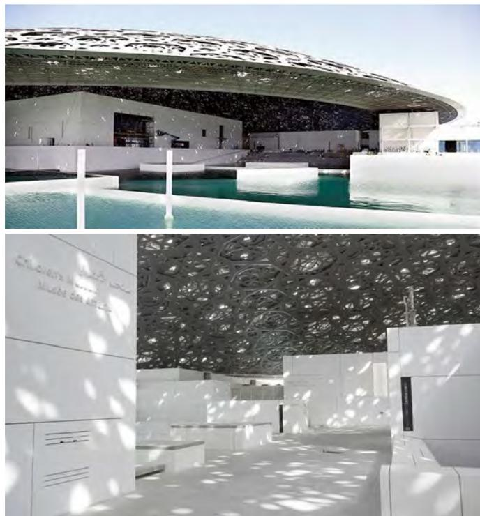
Рис. 15. Музей Лувр, Абу-Даби (Ж. Нувель, 2017 г.). Многослойная сетчатая структура купольного покрытия в условиях господствующего солнечного освещения обеспечивает бесконечно разнообразное «броуновское» движение многочисленных «зайчиков» по разно ориентированным объёмам выставочных павильонов под ним
