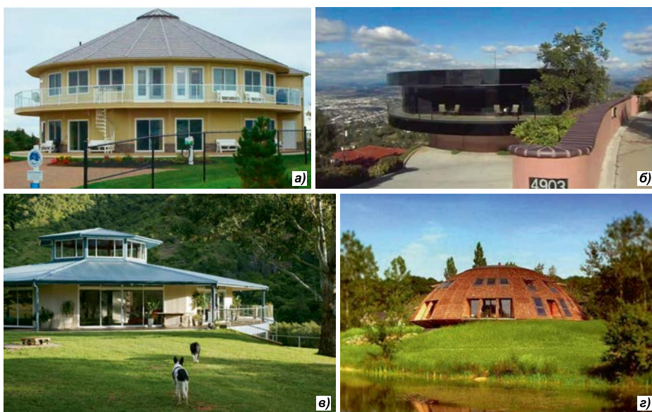
Рис. 4. Примеры домов, следящих (поворачивающихся) за Солнцем: а – двухэтажный дом «Вокруг света»; б – дом в Ла Месе (Калифорния, США); в – поворачивающийся дом «Эверингем»; г – купольный экодом («Dome House»)
