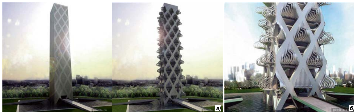
Рис. 5 – Проект « Kinetower »: а – общий вид в стационарном и трансформируемом состояниях; б – фрагмент фасада в процессе реакции оконных конструкций на интенсивность солнечного света. URL: http://www.chaoslend.ru/node/1651
