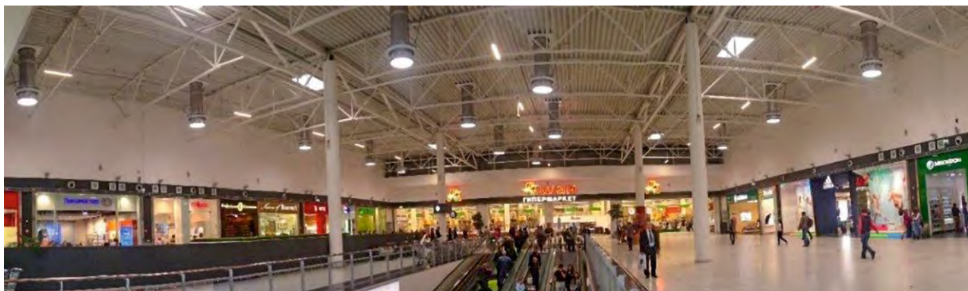
Рис. 4. Вид зала № 1 после реконструкции осветительной установки
