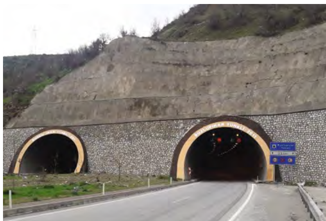
Рис. 3. Вид на две трубы тоннеля Buzlupınar
