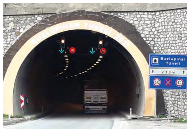
Рис. 4. Освещение тоннеля Buzlupınar светильниками с НЛВД
