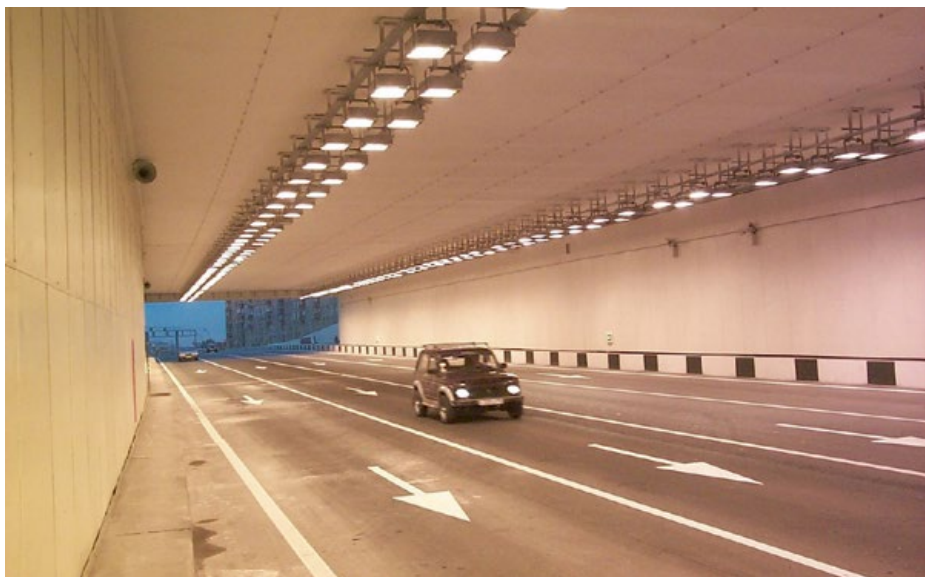
Рис. 4. Пример применения светильников Атлант ЖПУ-29 для освещения тоннелей
