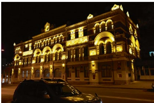
Рис. 10. Освещение здания Главпочтамта. Фото Н. И. Щепеткова
