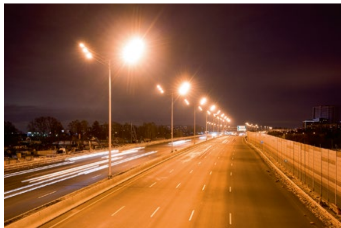
Рис. 4. Освещение автомагистрали М-11 (от Москвы до Шереметьево)
