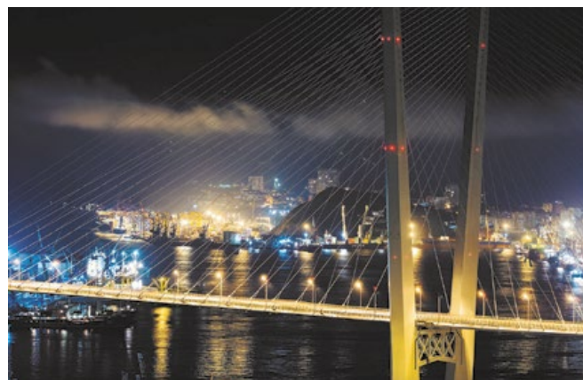
Рис. 15. Мост через бухту «Золотой Рог» в г. Владивостоке
