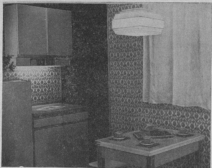
Рис. 8. Освещение кухни (светильники ФСБ01-2×30 и ФВБ02-30)
