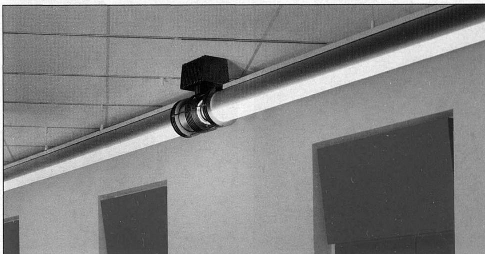
Рис. 1. Двухстороннее осветительное устройство серии SX100 с МГЛ мощностью 1000 Вт длиной 15,6 м
