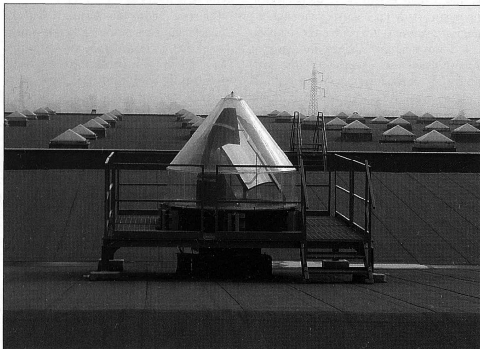
Рис. 4. Концентратор солнечного света, здание фирмы ЗМ, г. Карпиано
