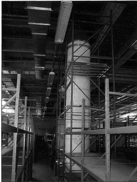
Рис. 7. Внешний вид вертикального световода
